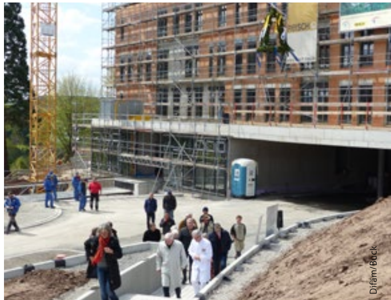
Seit dem Richtfest geht es auf der Baustelle zügig voran. Im Frühjahr 2017 soll das neue Bettenhaus eröffnet werden.
