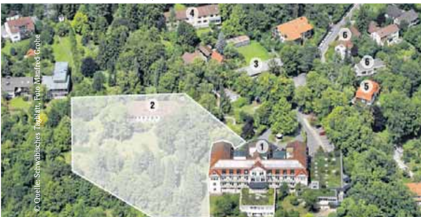
Tropenlinik Paul-Lechler-Krankenhaus (1), Verwaltungsgebäude der Missionsärztlichen Dienste (2), altes Medikamentenhaus (3), Gästehaus Haus Altblick (4), Chefarzthaus (5), zwei Schwesternwohnheime (6)
